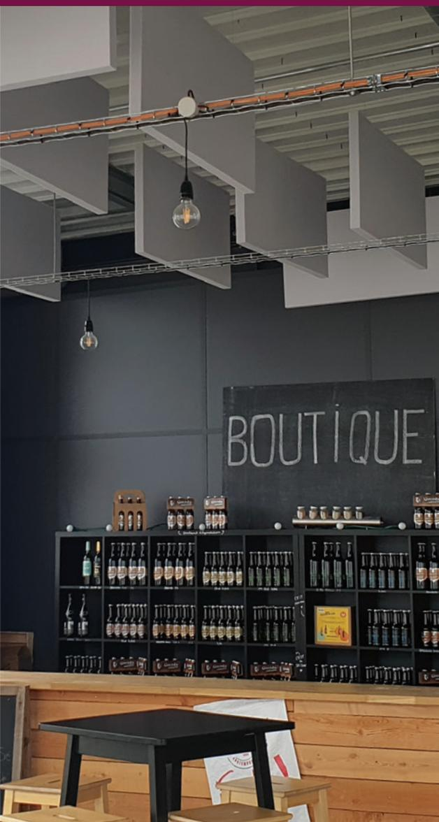
TECSOUND BAFFLE ACOUSTIQUE est un panneau de mousse de mélamine utilisé pour l'absorption du bruit et la correction acoustique des locaux. Le panneau TECSOUND BAFFLE ACOUSTIQUE offre d'excellentes qualités acoustiques grâce à sa structure à cellule ouverte. Les panneaux s'intègrent bien aux différents éléments d'aménagements intérieurs.
