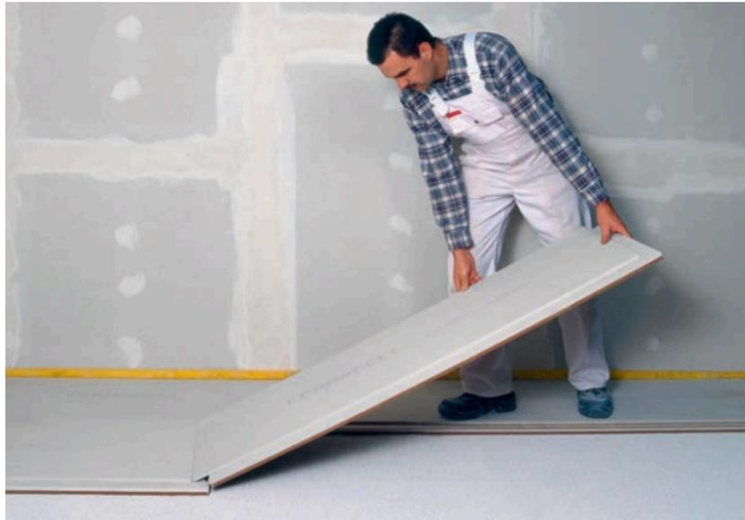
Figure 3 – Pose des chapes sèches Fermacell
