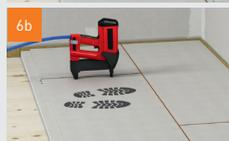
Pour assurer la pression de contact nécessaire, le poids du corps de l'installateur est placé sur la partie supérieure du fermacell®, en vissant ou en agrafant l'élément de plancher à l'élément inférieur.
