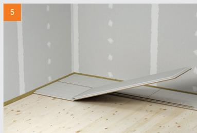
5 La colle assure le remplissage complet des joints
